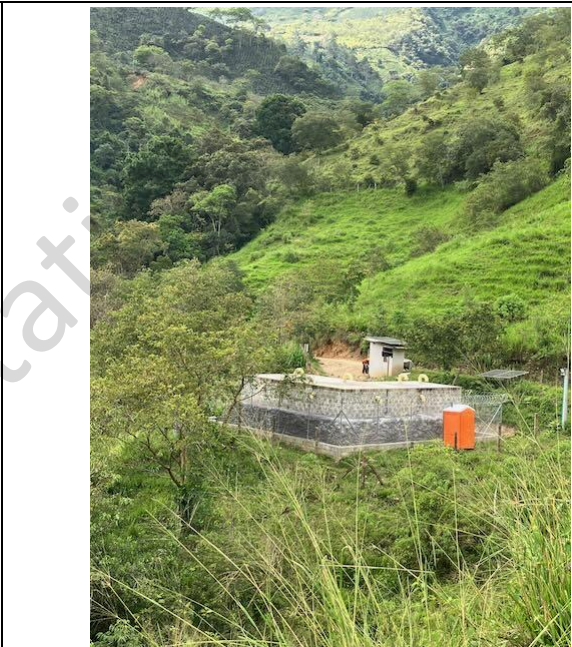
Foto 45: Edificio de almacenamiento de explosivos cerca de un depósito de escombros
