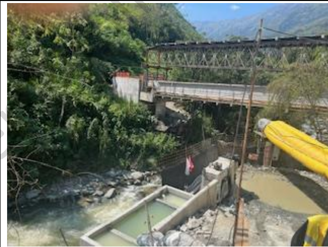
Foto 47: Mejora de la retención de sedimentos en Túnel superior portal , follow-up visit January 2024
