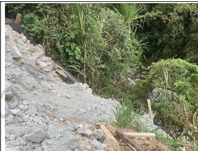
Foto 18: Depósito temporal de escombros en el portal superior del túnel, con riesgo de deslizamiento hacia el río
