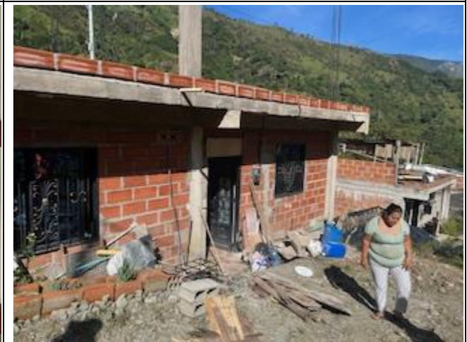
Foto 6: Vivienda de nueva construcción para la familia reasentada en San Andrés
