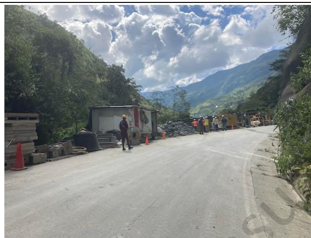
Foto 17: Sitio de trabajo con espacio restringido en la autopista cerca del portal superior del túnel
