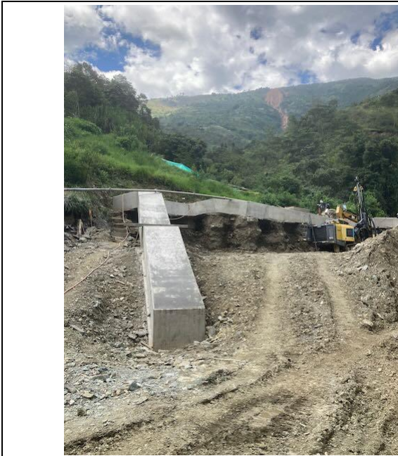
Foto 49: Muro de contención entre la futura central eléctrica de abajo y el depósito de escombros de la construcción de la carretera de arriba
