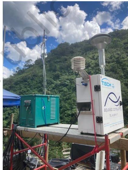
Foto 62: Equipo de monitoreo en el sitio de construcción de la casa de máquinas
